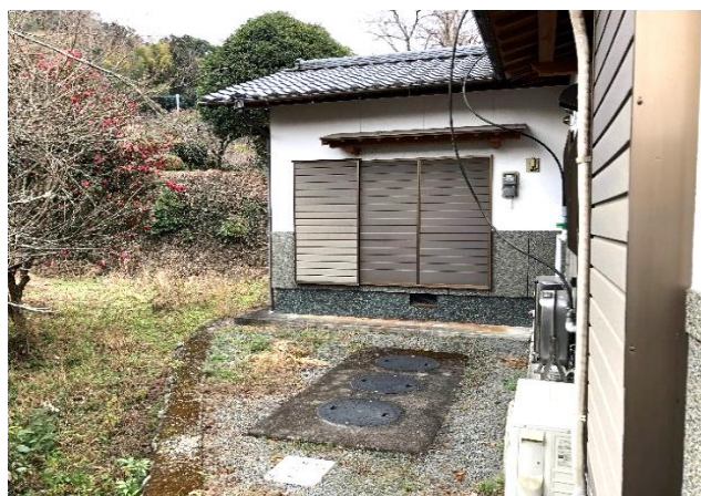
合併浄化槽
