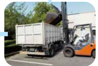
ダンプへ積み込み・金物選別
