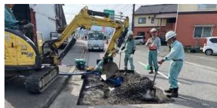
②漏水したところの補修
