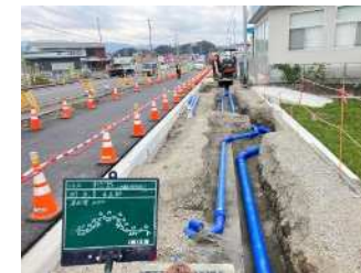
③水道管移設工事
